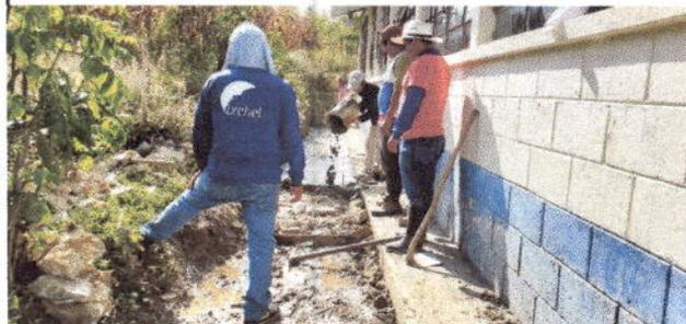
Foto 2: Reparacion de cuneta de concreto
