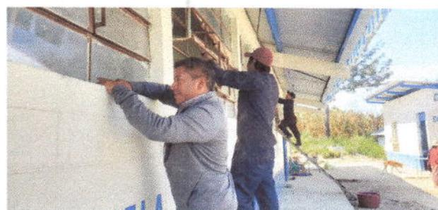
Foto 6: Sustitucion de vidrios, balcones de metal y canal para baja de agua
