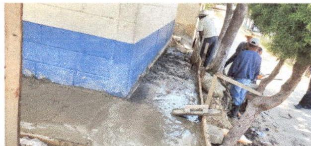
Foto 3: reparacion de banquetas de concreto
