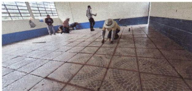
Foto1: Sustitución de piso ceramico antideslizante
